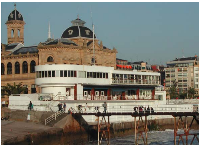
Vista actual del edificio del Real Club Náutico de San Sebastián desde el Puerto de San Sebastián
