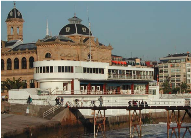
Vue actuelle du bâtiment du Real Club Náutico de San Sebastián depuis le Port de San Sebastián
